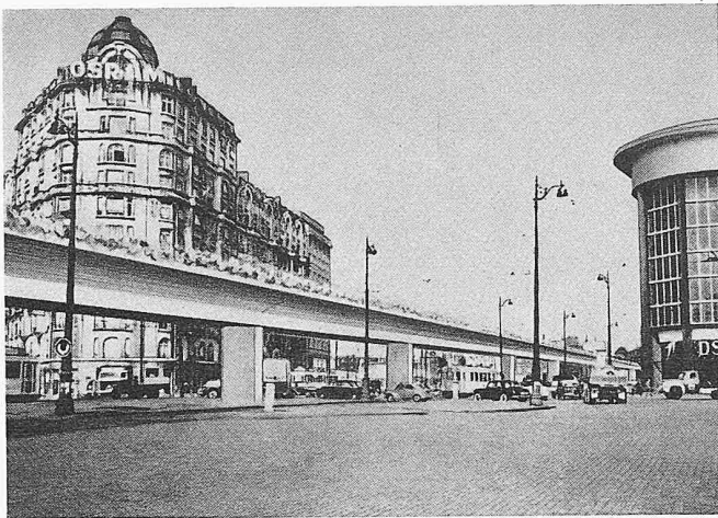
Bild 14. Hochstrasse über die Places de l'Yser et de Saintelette in Brüssel
