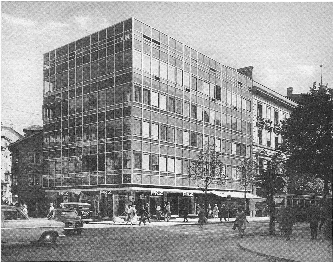
Geschäftshaus mit Läden, Bahnhofstrasse 46 Bauherr: Erbgemeinschaft Anton Waltisbühl Architekt: Rudolf Zürcher
