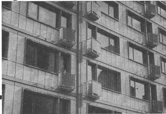
Ausfachung eines Beton-Skelettbauwerks
