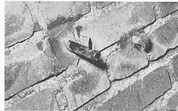
Bild 30 (links). Metallspitze in der Tunnelwand
