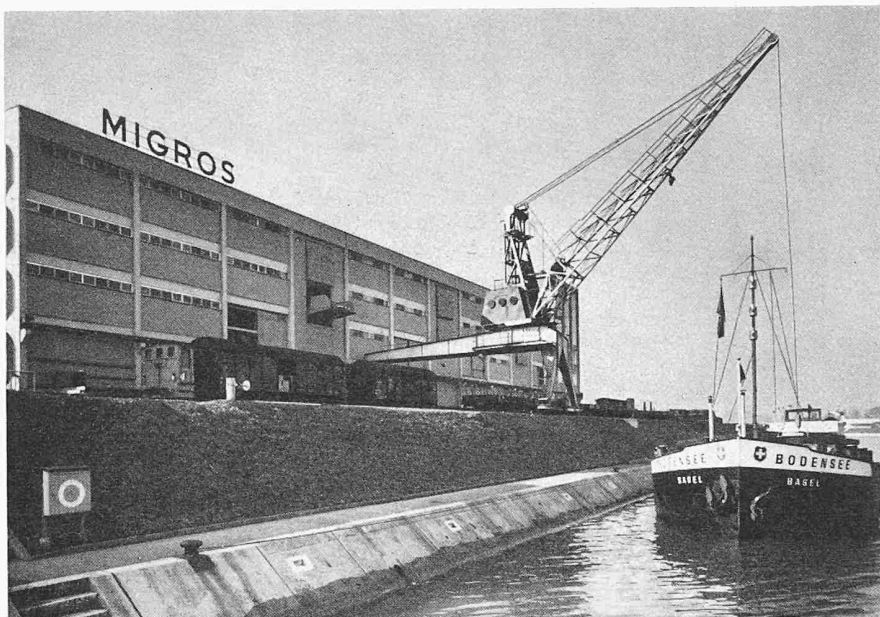
Bild 1. Das Migros-Kühlhaus am Rheinhafen Birsfelden
