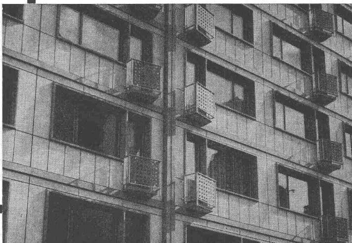
Ausfächung eines Beton-Skelettbaues
