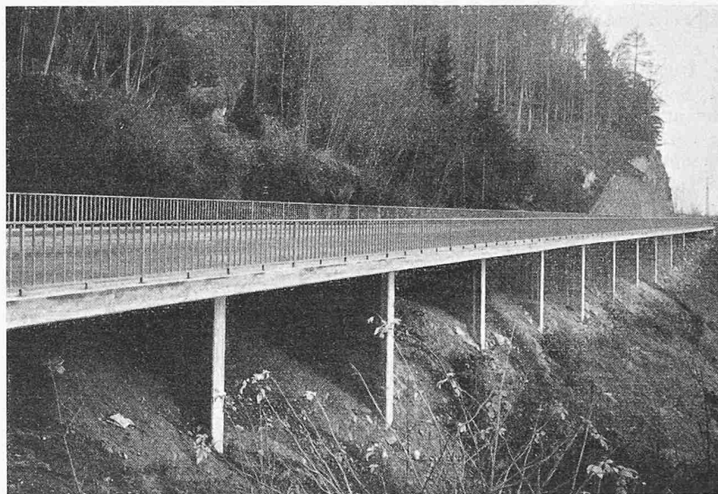
Bild 8. Lehnbrücke an der neuen Walenseestrasse
