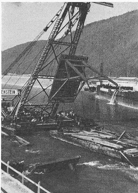
Bild 2. Versetzen eines Stauschildes
