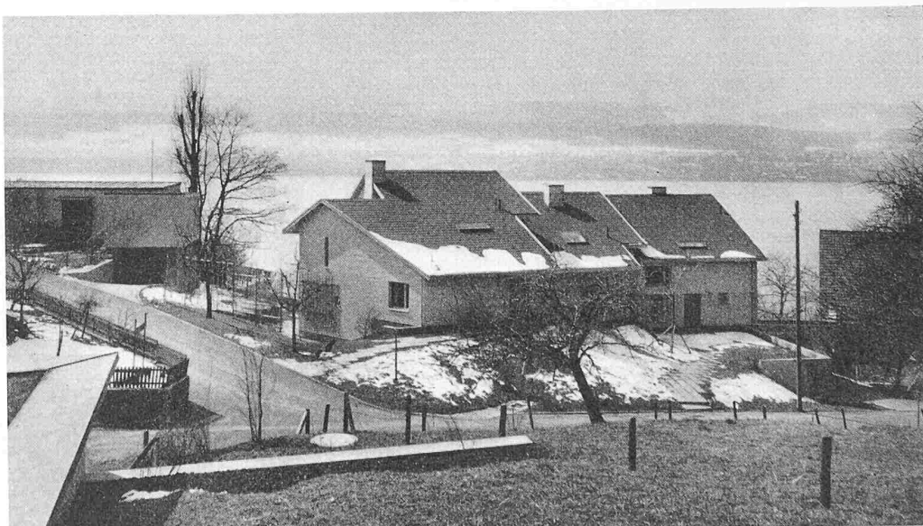
Dreiereinfamilienhaus in einem Zürichseedorf, gedeckt mit dunkelgrauen Eternitschiefern. Architekten Ed. Neuenschwander und M. Mettler
