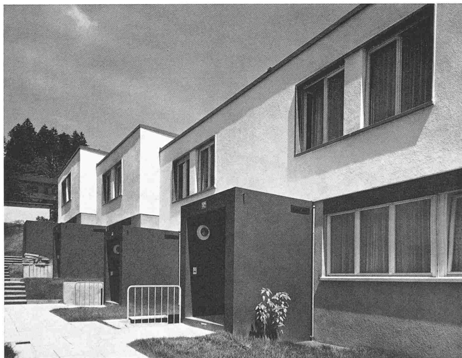
Eingangspartie der 2. Etappe aus Süden
