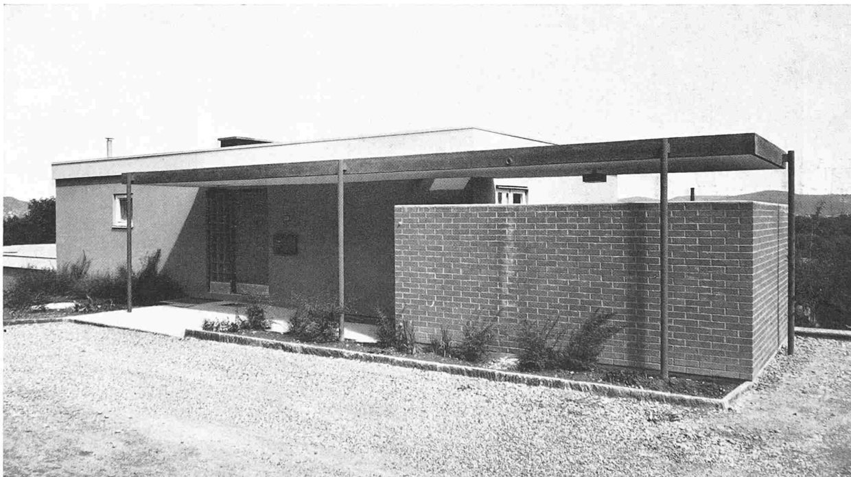
Eingangspartie der 1. Etappe aus Nordwesten
