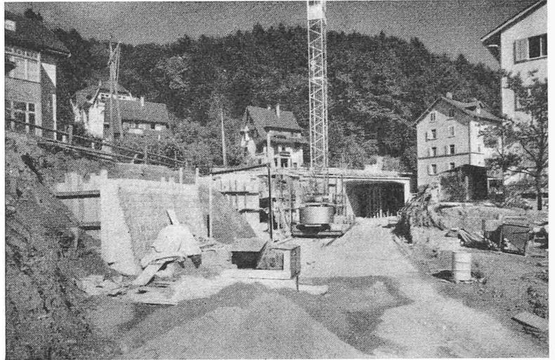
Bild 13. Südlicher Voreinschnitt des Bahntunnels mit Zürcherstrasse-Unterführung (Foto W. Müller, Baden)
