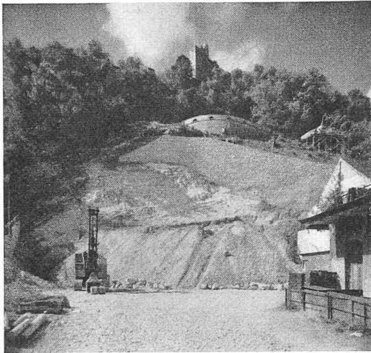
Bild 12. Abtragung und Stützmauer für den nördlichen Voreinschnitt des Bahntunnels (Foto W. Müller, Baden)
