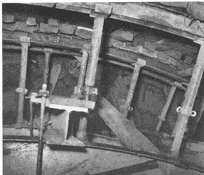
Bild 16. Tunnelbau, Abstützung der Marciavanti-Spriessung auf die inneren Lehrbögen (Foto W. Müller, Baden)
