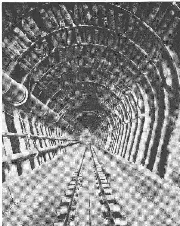
Stollen mit Stahleinbau in gebrächem Fels
