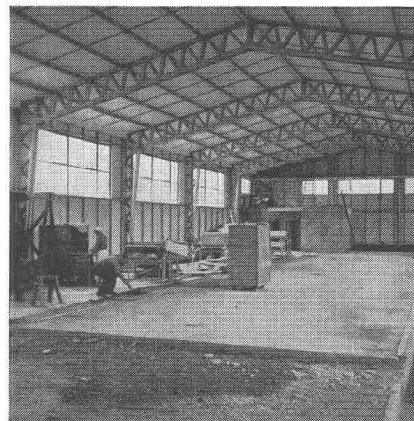
Die neue Fabrikhalle der Int. Verbandstoff-Fabrik Neuhausen a. Rheinfall
