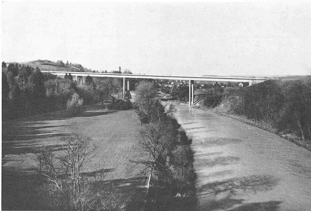
Ansicht der Weinlandbrücke aus Osten (Oberstromseite) mit Andelfingen im Hintergrund
