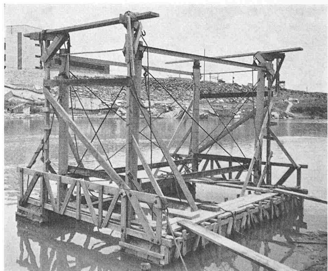
Bild 6. Mit diesem Floss wurden alle Pfähle eingeschwommen, Aufstellen und Absenken mit je einem Flaschenzug pro Eckpfosten
