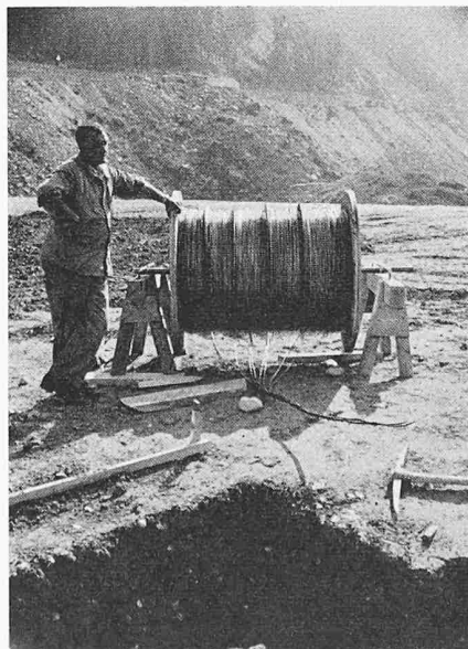
Bild 7. Kupferröhrchen der Druckzellen, bereit zum Auslegen in die Gräben.
