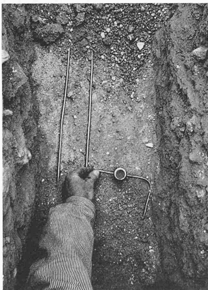
Bild 5. Piezometerdruckzelle vor dem Einbau in der Kernzone.
