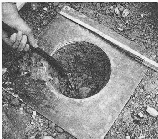
a) Ausheben des Probeloches
