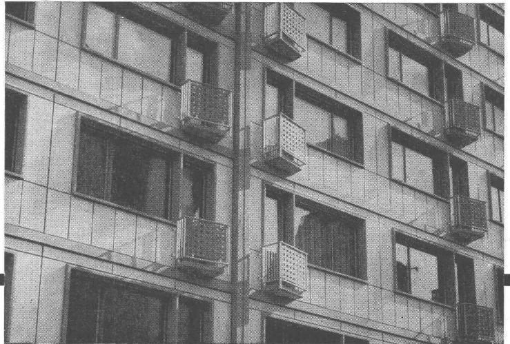
Ausfächung eines Beton-Skelettbau
