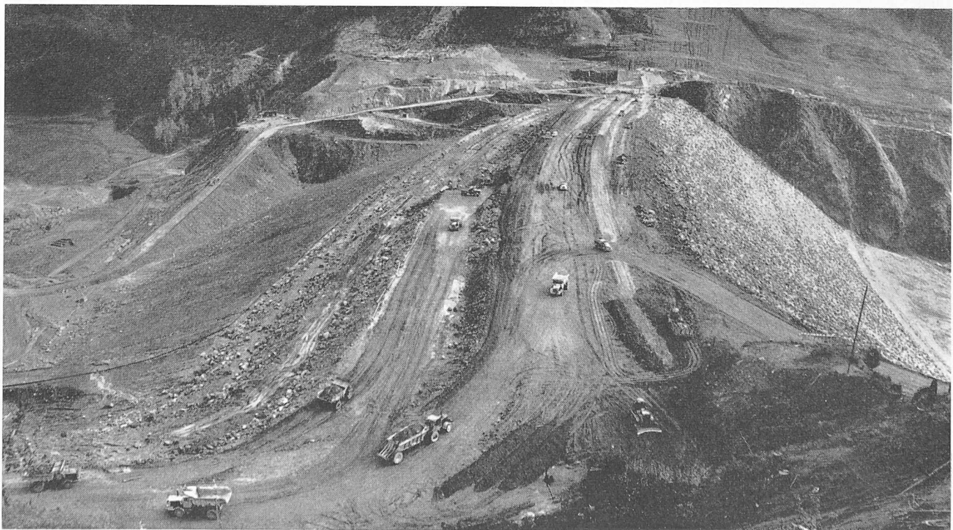
Bild 18. Einbau des Swift-Dammes vom rechten Widerlager aus (25. 9. 1958)
