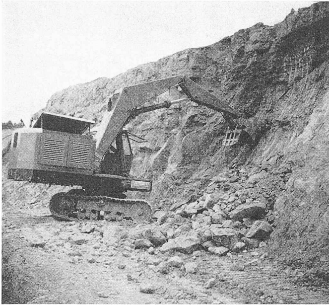
Bild 3. Abbau des Tonmergels mit hydraulischem Bagger
