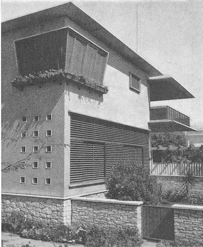
Die Südwestfassade mit den durchbrochenen Holzwänden als Sonnenschutz
