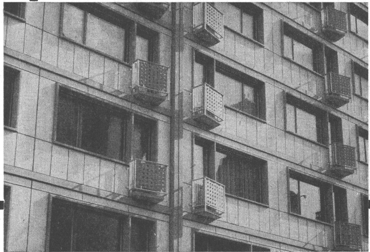
Ausfachung eines Beton-Skelettbauens
