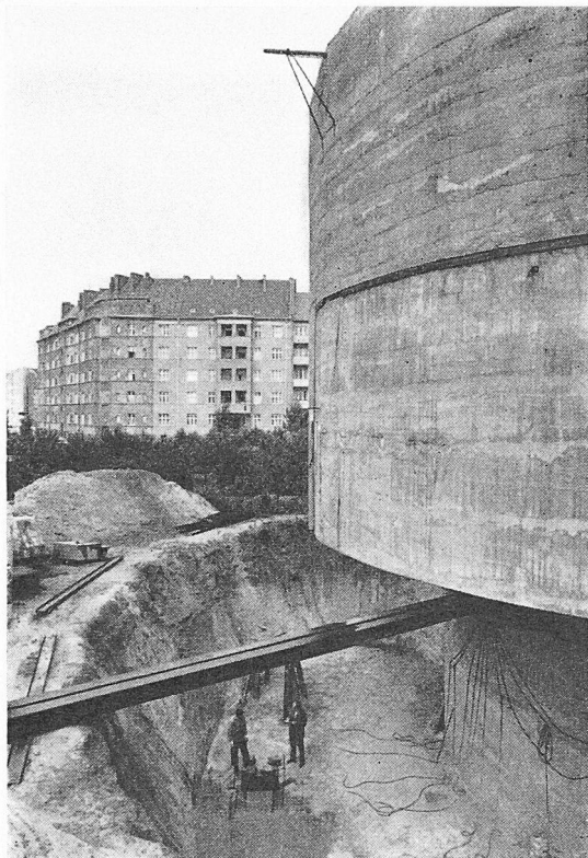
Bild 9. Versuchsgrube am Pilz-Bauwerk
