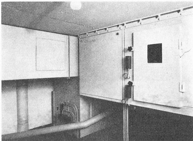
Bild 14 (links). Klimaaggregat für den Vortragssaal (Teilan-sicht)
