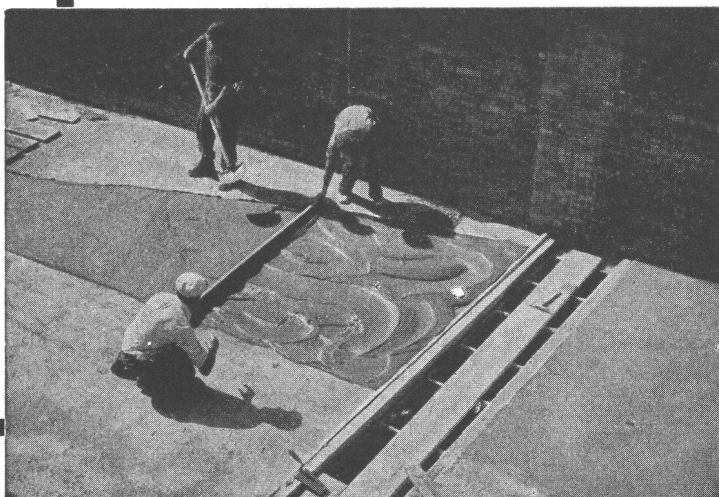
Flachdach zweischichtig, begehbar
