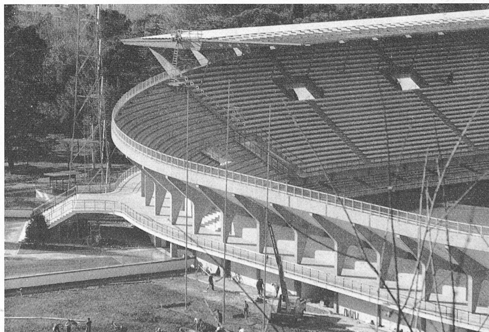
Bild 9. Stadio Flaminio, Haupteingang und Rahmenkonstruktion, 15 m auskragendes Tribürendach
