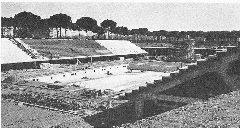
Bild 11. Zuschauertribüne des Schwimmstadions, mit Travertinplatten verkleidete Eisenbetonkonstruktion
