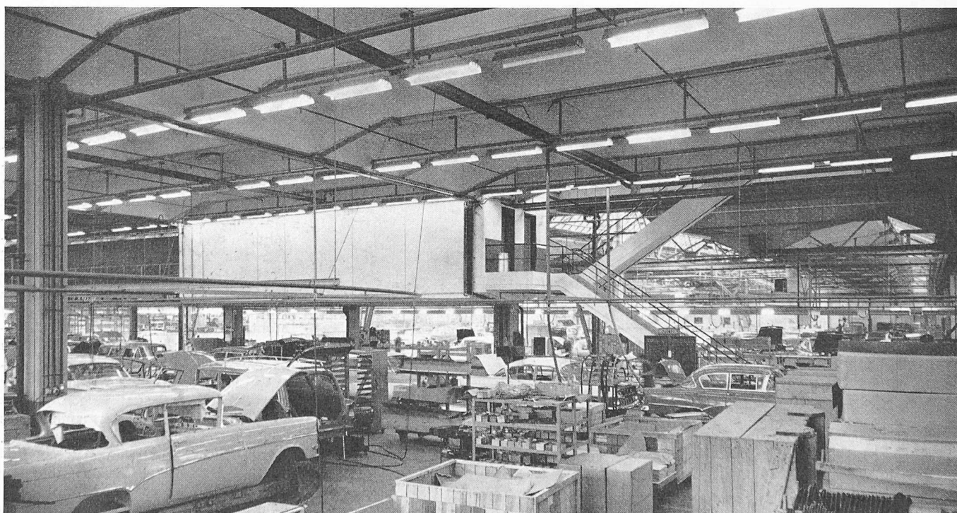
Bild 7. Erdgeschoss des Neubaus mit Blick auf die in einem Mezzanin untergebrachten WC und elektrischen Verteilanlagen; Durchblick zur alten Fabrik
