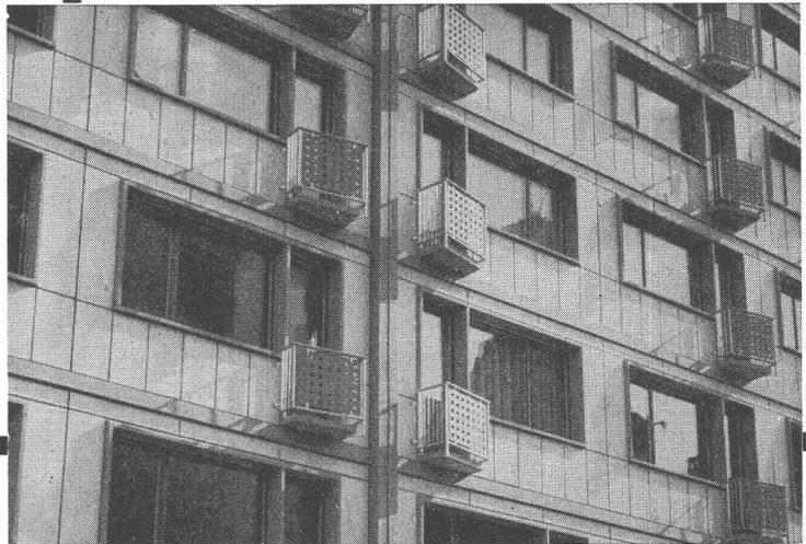
Ausfachung eines Beton-Skelettbauwerks
