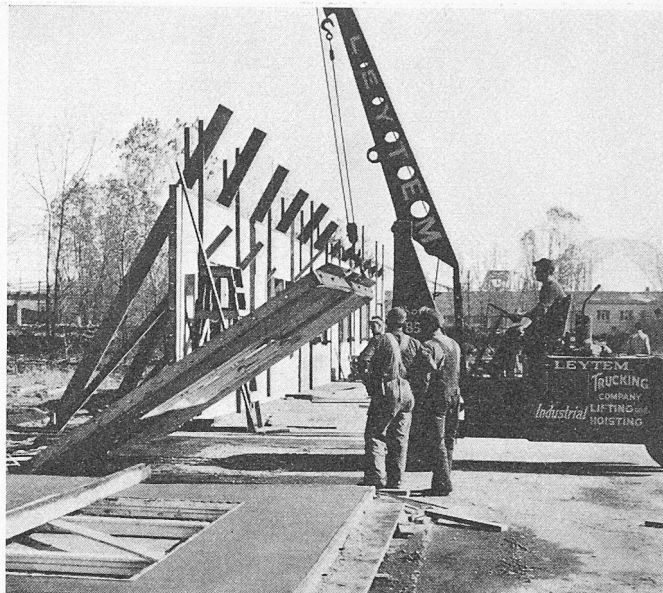
Bild 3. Tilt-Up-Konstruktion. Man beachte die drei Phasen: Betonieren am Boden, Aufklappen und provisorisches Verstreben in der Endlage. Photo Portland Cement Association, Los Angeles, California
