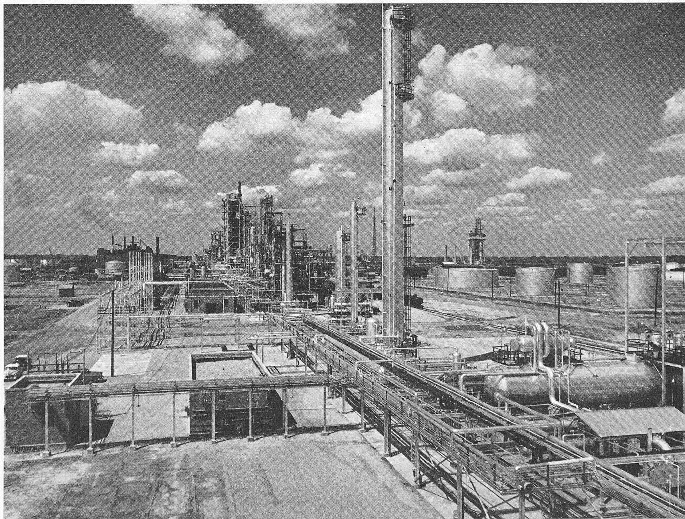
Alkylierungs-Anlage der Ohio Oil Co. in Robinson, Ill., USA, wo leichte Kohlenwasserstoffe (Butylene und Isobutan) zu hochwertigen Isooktanen vereinigt werden, welche vor allem als klopfeste Komponente moderner Flugbenzine Verwendung finden. Im Vordergrund rechts das Reaktionsgefäss (liegender Tank), in welchem die Vereinigung vor sich geht. Dahinter die zur Trennung der leichten Kohlenwasserstoffe dienenden hohen Fraktionierkolonnen. Im Hintergrund weitere Erdölverarbeitungsanlagen
