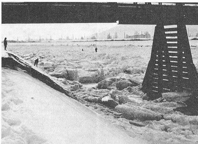
Bild 5 Eisgang auf dem Rhein bei der Brücke Monstein während der Erstellung der Fundationen (Winter 1955/56).
