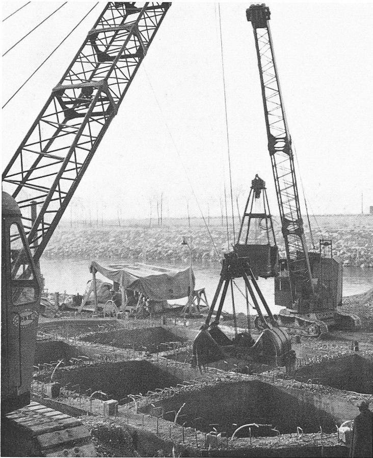
Senkkasten Strompfeiler Seite Oesterreich im Absenken begriffen
