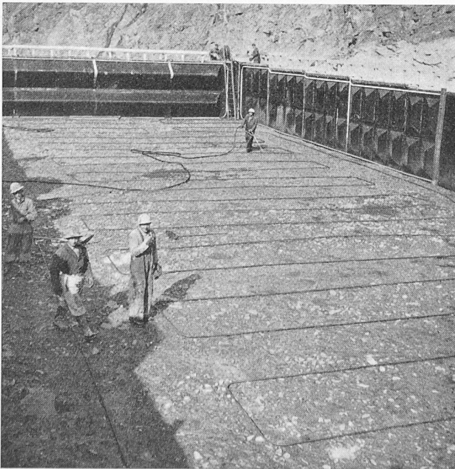
Fig. 2. Un bloc avant le bétonnage, serpentins de réfrigération (été 1954)
