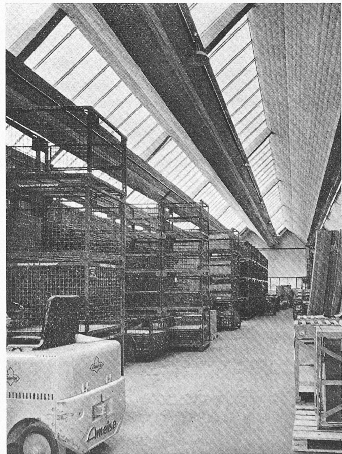
Bild 12. Innenansicht der fertigen Halle
