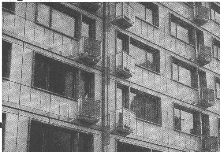
Ausfachung eines Beton-Skelettbau
