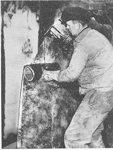
Bild 6. Aussenisolierung im Giess- und Einwalzverfahren
