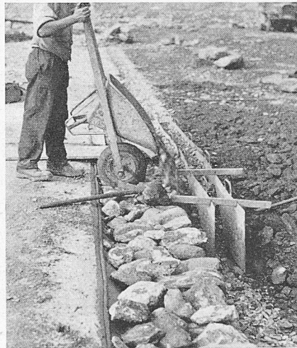
Bilder 8 und 9. Becken Safien-Platz, Drainage und Filterschicht beim Entwässerungssystem
