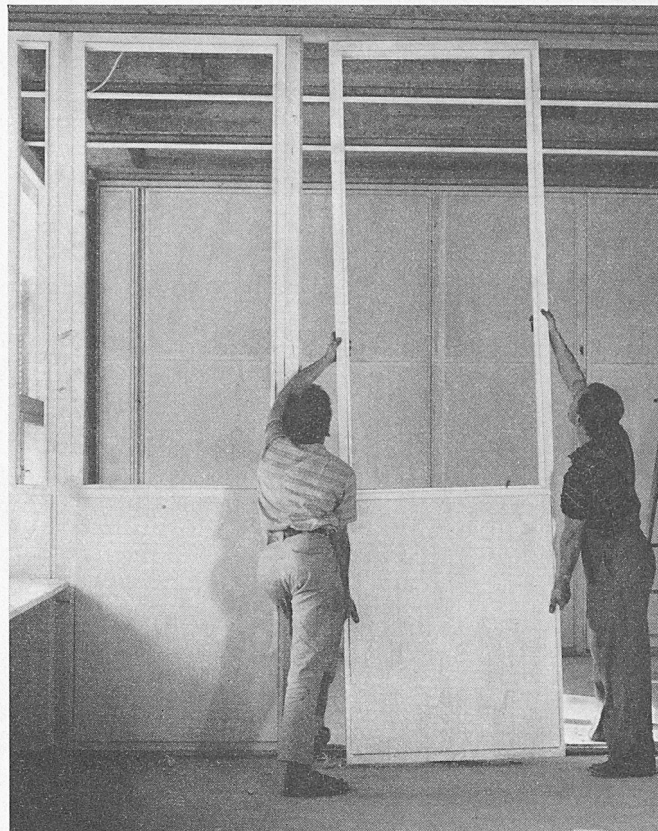
Aufstellen der demontablen Zwischenwände
