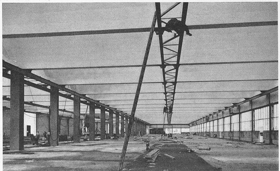
Bilder 6 und 7. Die Weichenbauhalle im Rohbau (Kranbahnmontage)
