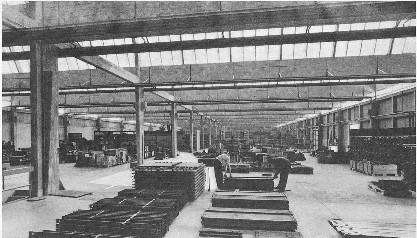
Bild 22. Blick in das Kleinmaterialmagazin
