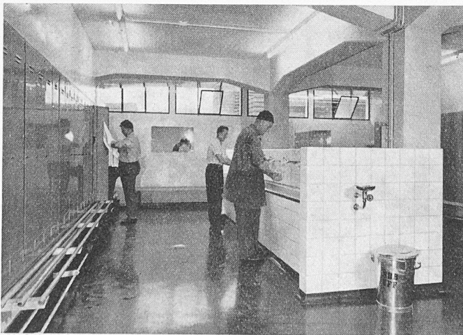
Bilder 30 und 31. Stahlchränke mit feuerverzinkten Sitzbänken und Schuhraster, Waschrinnen und Waschfontänen im Umkleideraum
