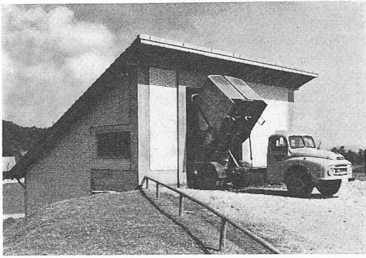
Bild 5. Müllverwertungsanlage Uzwil (Bühler-Verfahren)
