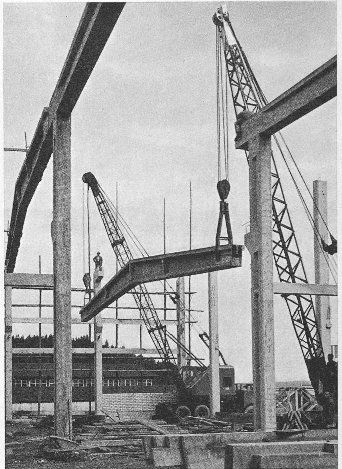
Bild 24. Versetzen eines vorgespannten Riegels
