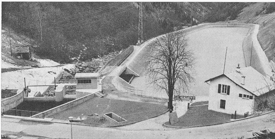
Bild 16. Herbst 1959, Ausgleichbecken und Wasserfassung in Betrieb, Blick talwärts
