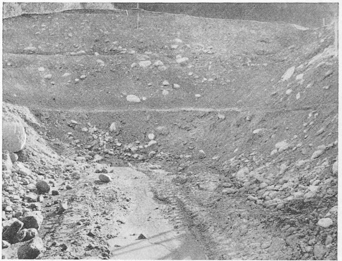
Bild 3. Herbst 1957; grosser, mit Trax ausgeführter Sondierschlitz
