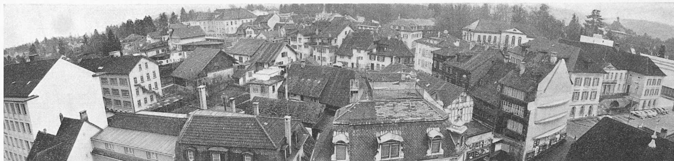
Heutiger Zustand des Behmenquartiers von Norden mit den seitlichen Begrenzungen: links Neubau der Kreditanstalt, vorn Gebäude entlang der Bahnhofstrasse, rechts vor dem Regierungsgebäude: Häuserreihe entlang Oberer Vorstadt, rechter Bildrand: Kunsthaus
