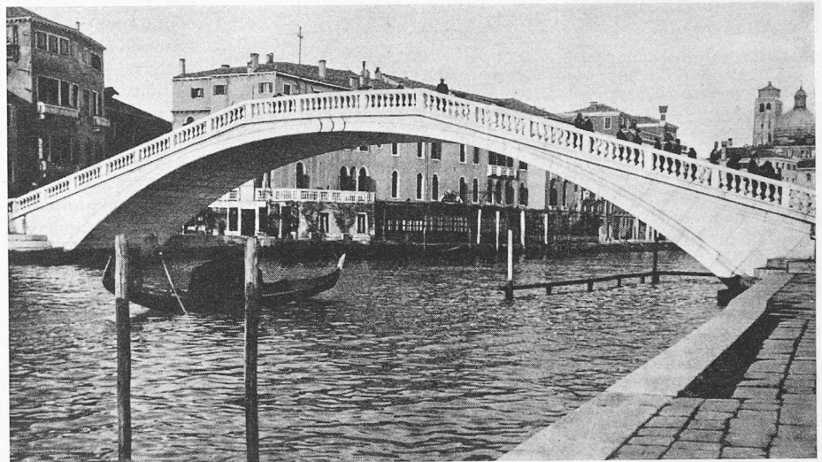
Bild 12. Scalzi-Brücke, in klassischer Bauweise aus Kalksteinquadern ausgeführt und auf Pressbeton-Ortopfahle abgestellt (Blick in den Canal Grande von S. Simeone Piccolo aus; der Bahnhof liegt links)
