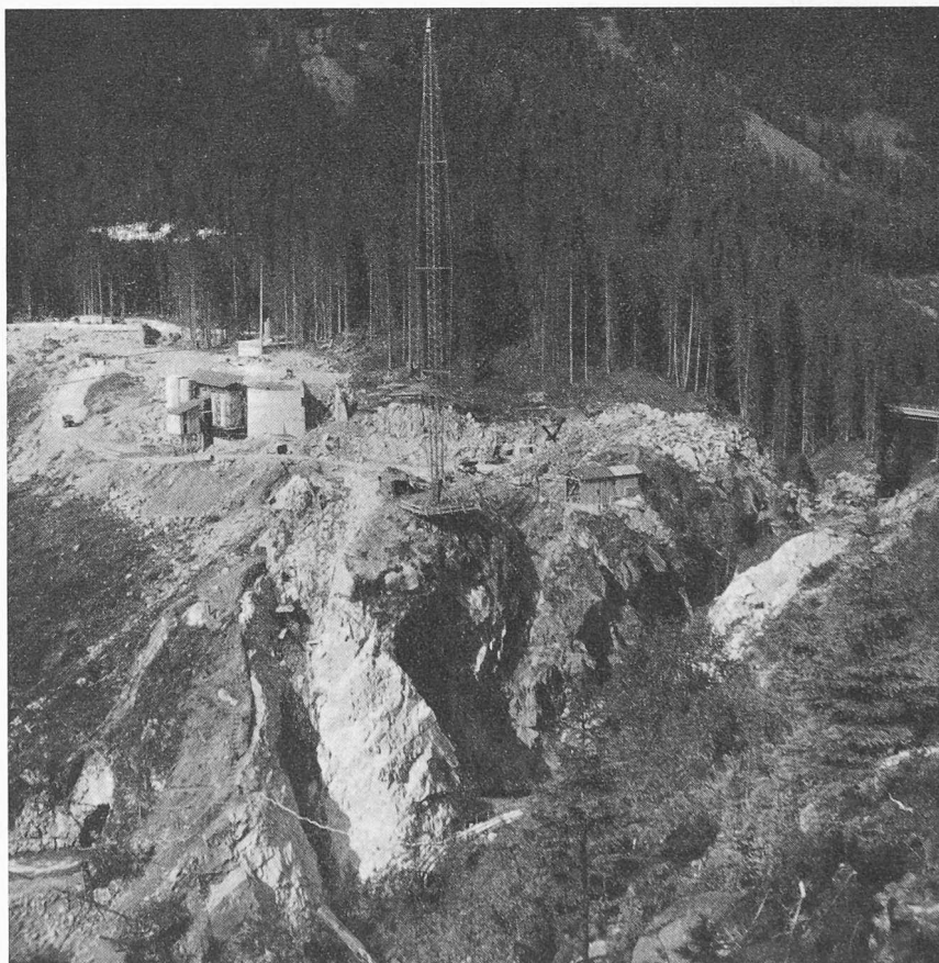
Bild 1. Sperrstelle Sufers aus Süden, Anfang Juli 1960. Im Vordergrund der linksufrige Fundamentschlitz für die Bogenmauer in der Hinterrheinschlucht. Links der Einlauf des Umleitstollens. Auf dem Crestawaldrücken der 6-t-Derrick mit 60 m grösster Ausladung für die Staumauerbetonierung. Die Betonmischanlage ist links an einen bereits erstellten Teil der bergseitigen Wand der Hochwasserentlastung angelehnt, deren Ablaufrinne sich im Aushub befindet. Ganz hinten links ein Stück der aus dem Staugebiet verlegten neuen Kantonsstrasse, bis zu welcher sich der niedrige Flügeldamm auf dem Crestawaldrücken erstreckt
