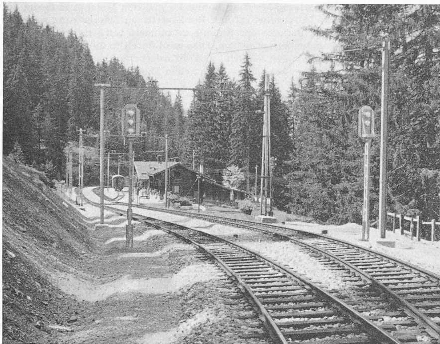
Bild 5. Die Station Cavadürli aus Südosten. Im Vordergrund die beiden Gleis-Ausfahrtsignale C 1 und C 3 , hinten die mit Weichenschlüssel gesicherte Anschlussweiche mit einem abgestellten Bahndienst-Fahrzeug
