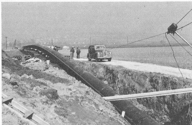
Bild 2. Der Düker zu Beginn des Einziehvorganges
