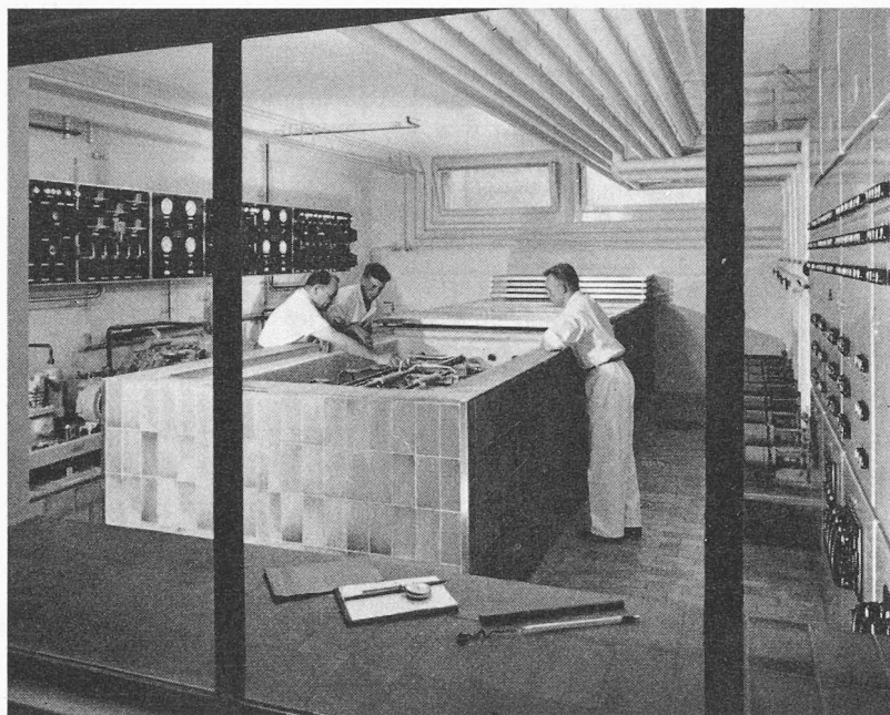
Bild 8. Kältezentrale; links unten: Kompressor-Aggregate, darüber Kältemittel-Verteiltableau; Mitte: die beiden Eiswasserbehälter; rechts hinten: Eiswasserpumpen mit Eiswasserleitungen; rechts vorn: elektrisches Verteiltableau
