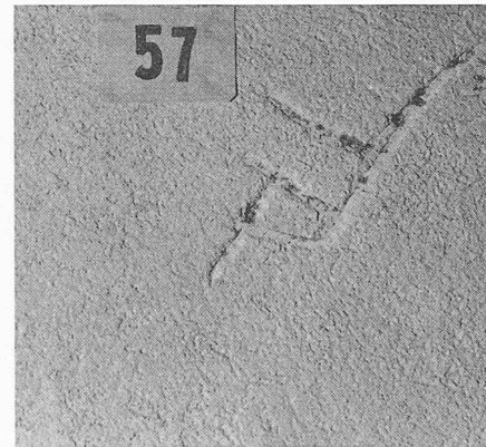
Nr. 57: Schalung ungeölte Eisenplatte. Plafonit haftet sehr gut
