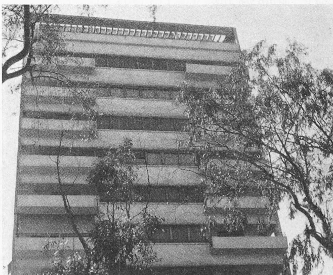
Bild 12. Wohnturm in Kairo: Eisenbetonskelettbau
