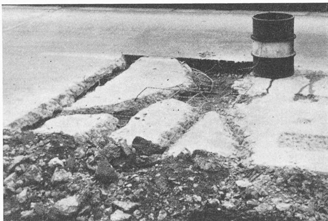
Bild 6. Fahrbahnplatte der Bundesautobahn nach dem Entfernen des losen und beschädigten Betons und Säubern der Flächen des alten Betons mit Druckluft und Wasser. Rechts bis auf den Unterbeton ausgestemmte Verschleisschicht
